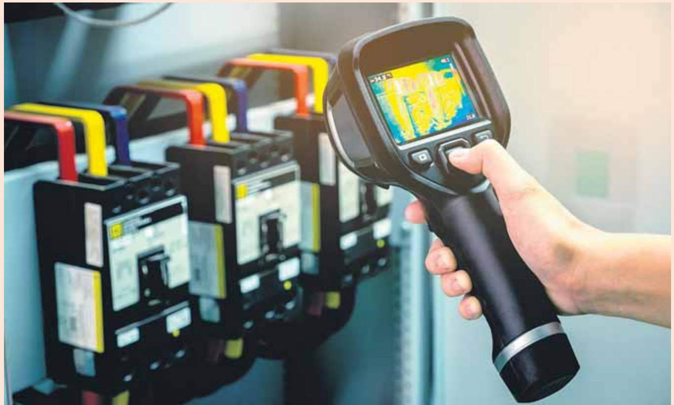
ESTALVI ENERGÈTIC. La termografia permet detectar on s'estigui produint malbaratament d'energia
